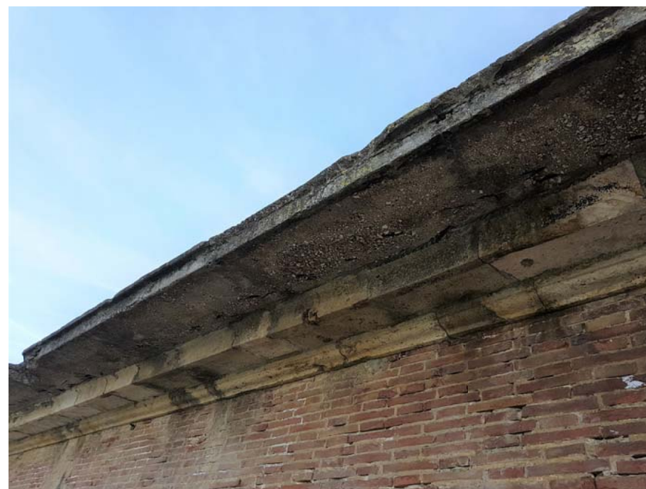
ALTRO ESEMPIO DI DETERIORAMENTO DELLA SOLETTA. PARTICOLARE DELL'INFRADOSSO DA CONSOLIDARE. SI NOTANO ANCHE LE "OMBRATURE" DEI PROFILI IN ACCIAIO A SBALZO. ANCHE SE CON DIFFICOLTÀ NELL'INDIVIDUARLI ALCUNI TRATTI SONO STATI REALIZZATI CON I PROFILI TIPO NP CHE CON LA SOLA ARMATURA A SBALZO TIPO "MOLLE" O MISTI
